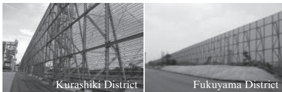
写真 1 石炭ヤードに設置した防風フェンス Photo 1 Windbreak of coal stock yard
